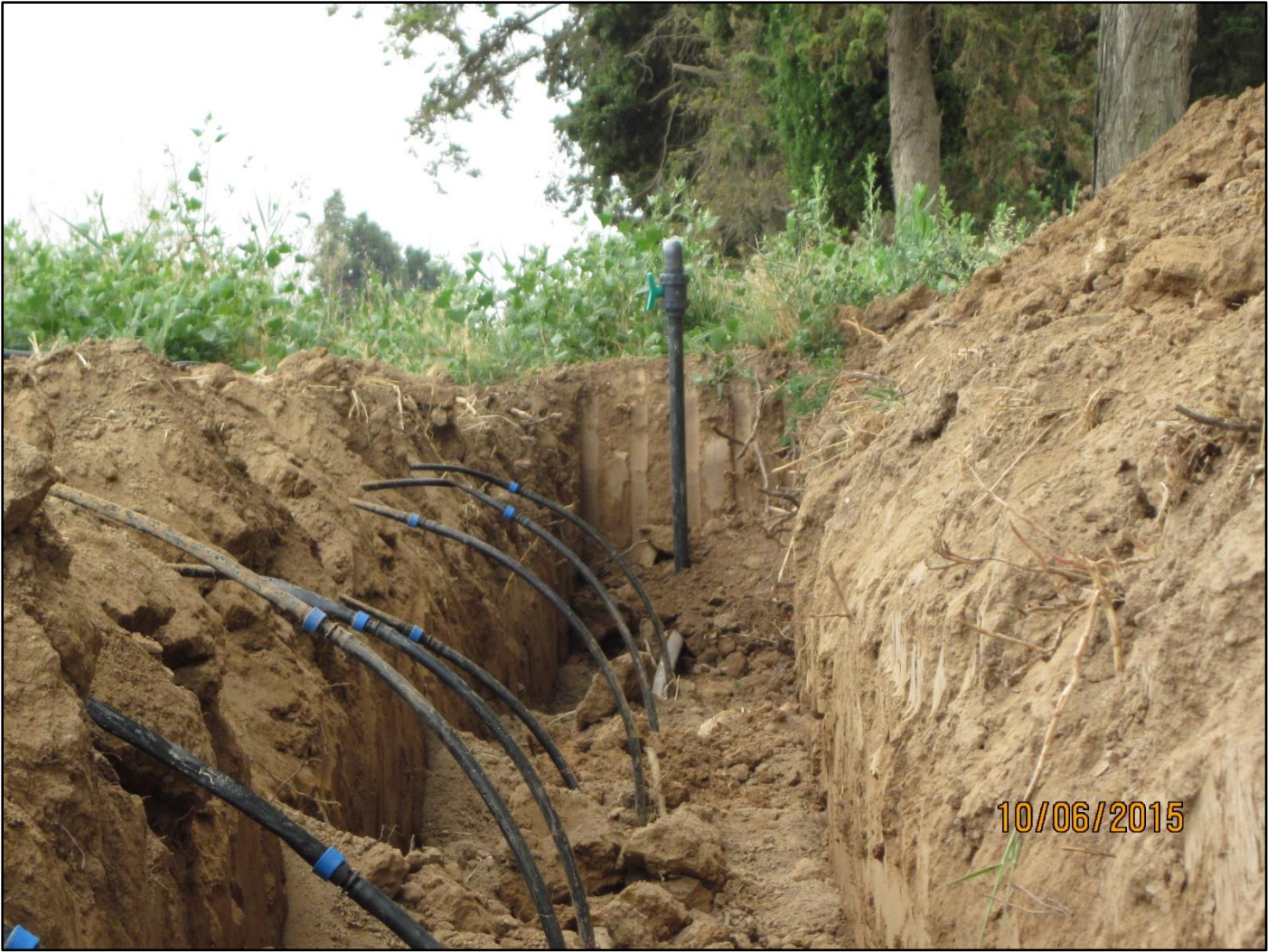
Figura 15. Desagüe de las mangueras en el colector final y válvula de limpieza al fondo de la zanja.
