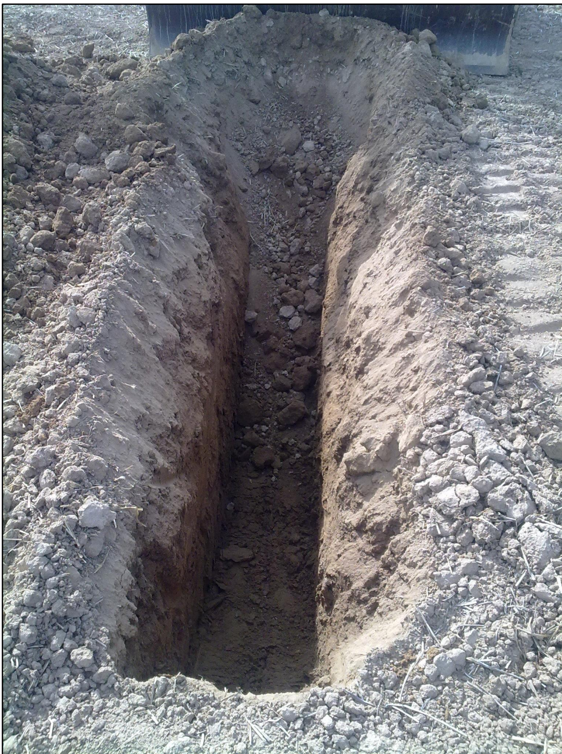
Figura 10. Excavación de zanja realizada con retroexcavadora previamente a la implantación del ensayo.
