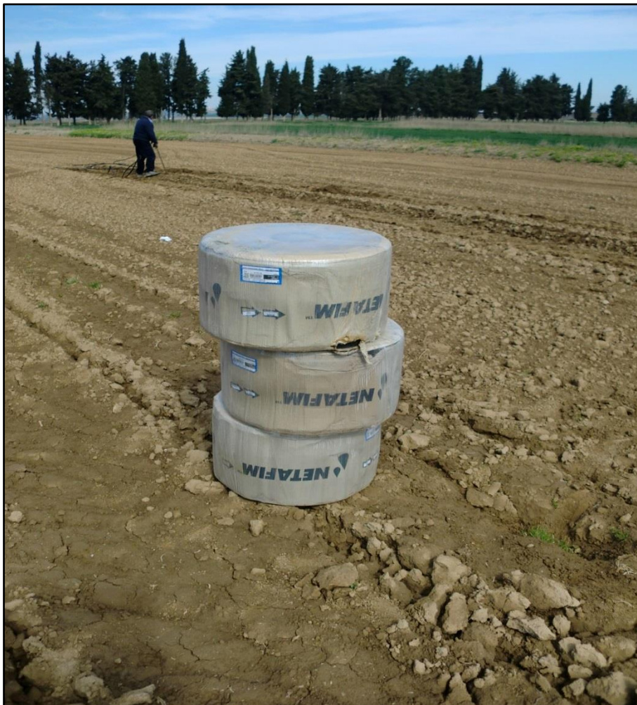
Figura 12. Conjunto de rollos de mangueras porta-goteros previamente a su enterrado.
