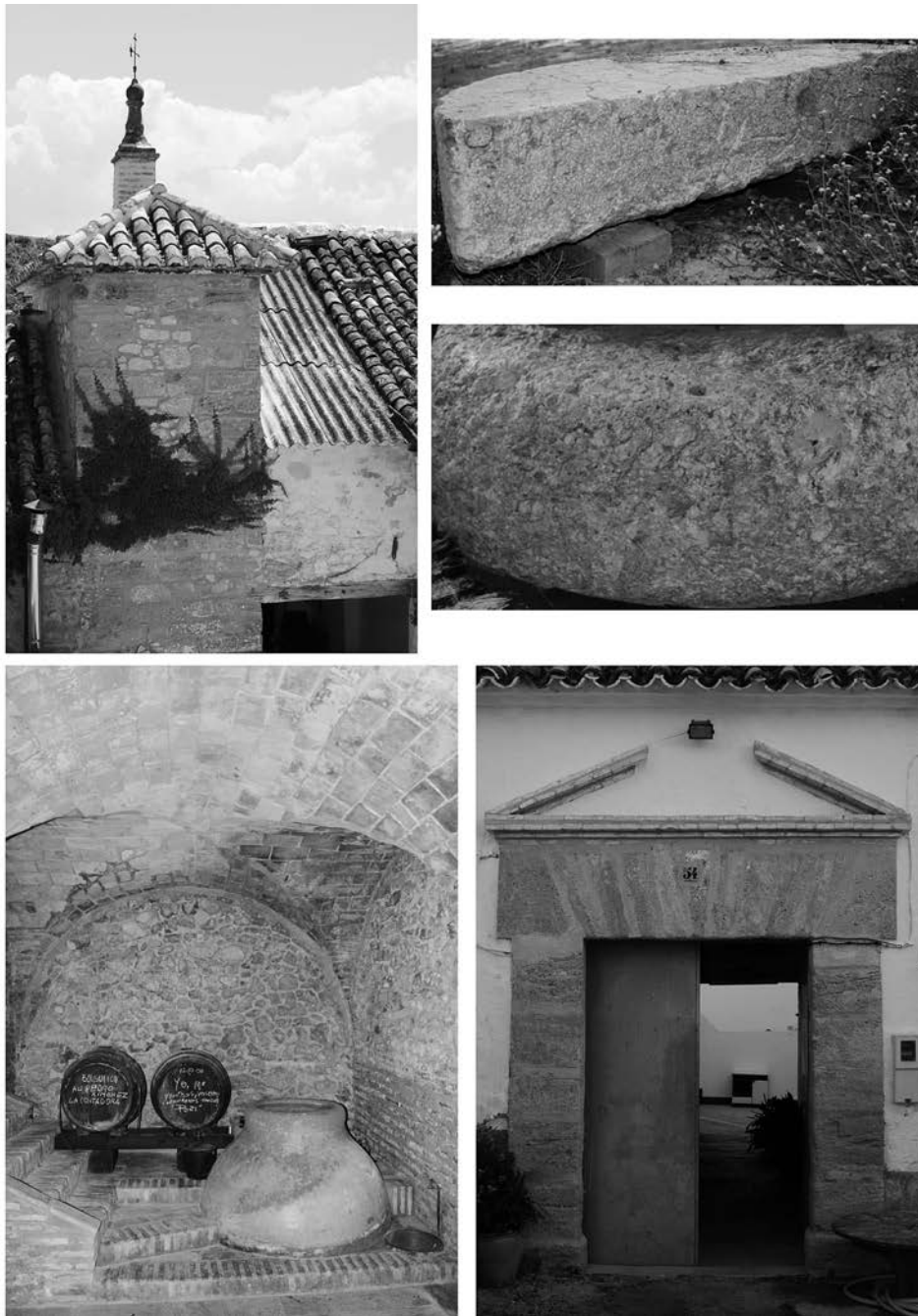
Lámina 6. Fotografías realizadas en el Molino del Toro: torre de contrapeso, empiedro y quintal (arriba); bodega de aceites y portada principal de acceso (abajo). Autor: A. Moreno.
